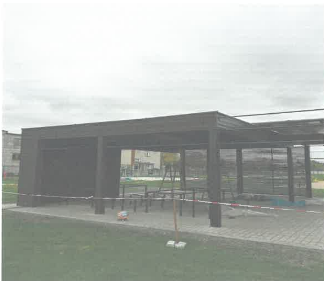
remont wiaty na placu rekreacyjno sportowym przy ul. Kochanowskiego
