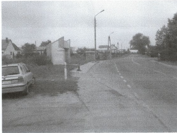
Ciąg komunikacyjny z chodnikami i oświetleniem do remontu
