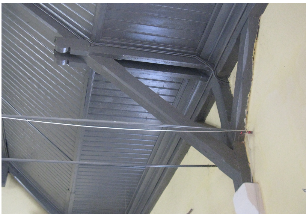
Zdjęcie nr 2 – Widok oparcia konstrukcji
