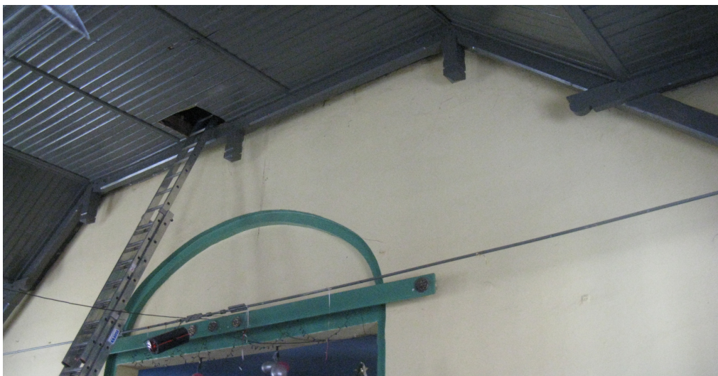
Zdjęcie nr 1 – Widok konstrukcji nośnej dachu
