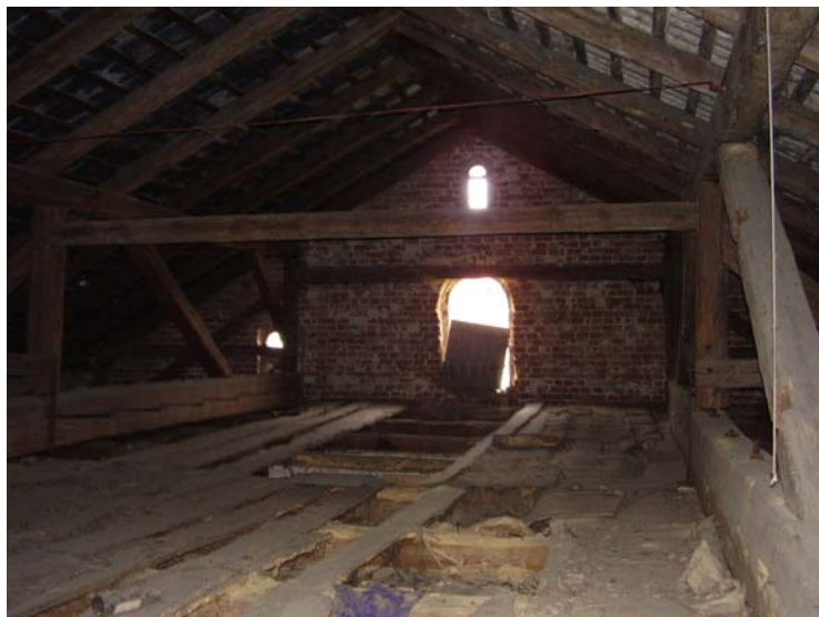
Poddasze budynku świetlicy
